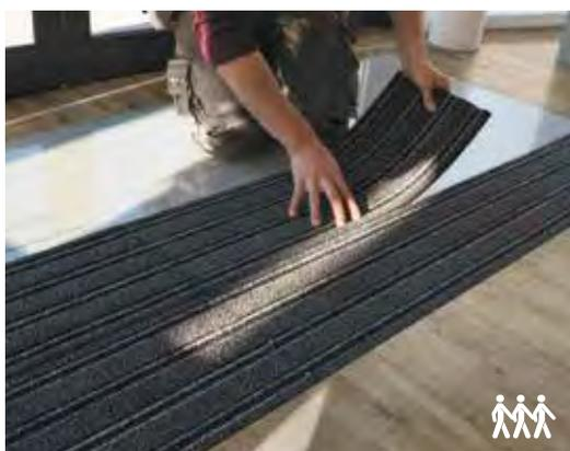
Questo zerbino d'ingresso modulare può essere inserito in una pavimentazione Gerflor LVT senza danneggiare il sottofondo. Aiuta a pulire la suola delle scarpe e protegge l'edificio dallo sporco esterno. Adatto per superfici caratterizzate da alto traffico pedonale (fino a 500 persone al giorno).
